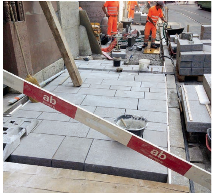
Pose de dalles à la Gerbergasse
