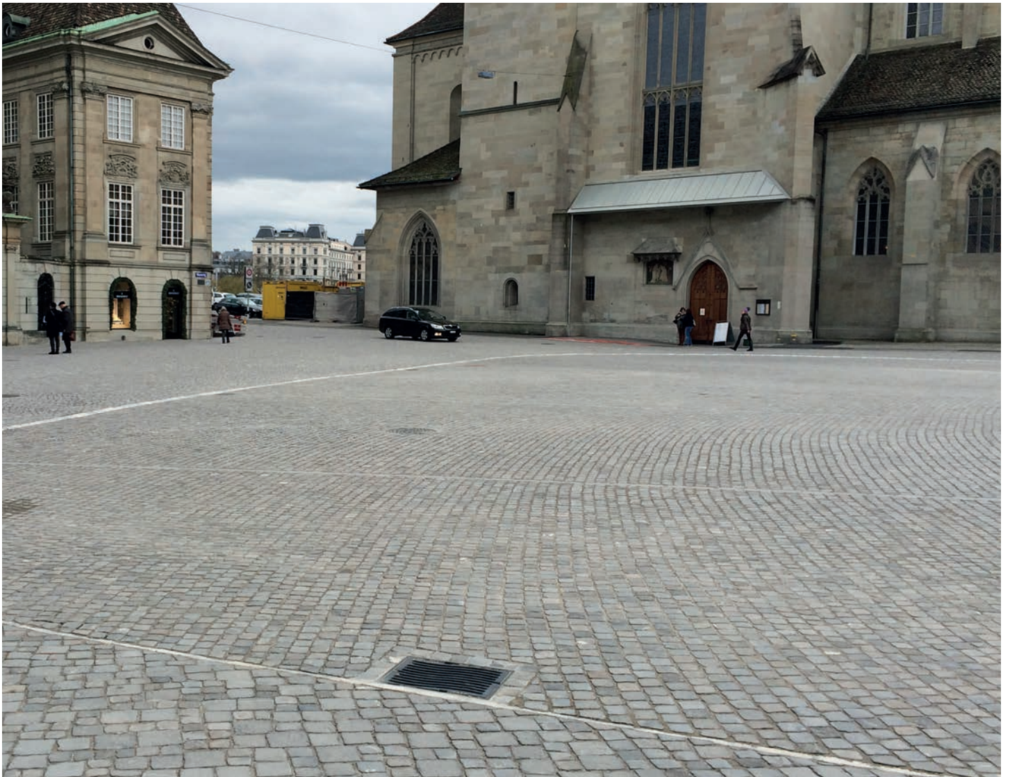
Place du Münsterhof à Zurich: pavage circulaire avec pavés type 8/11, adapté aux handicapés
