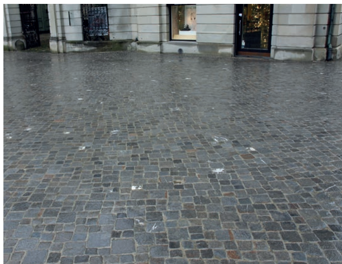
Les pavés récupérés de type 7/9 et 8/11 ont été traités à la carrière GUBER (nettoyés, abrasés et flammés).
