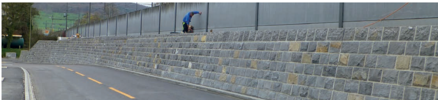
Mur de soutènement à la Güterstrasse à Sissach lors des dernières finitions.
