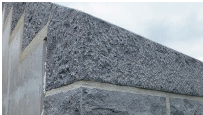
Détail de blocs bruts dégauchis à la montée d'escaliers
