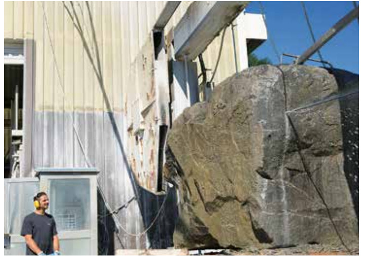
Scie à câble Candiani, année 1992, pour équarrir de blocs bruts
