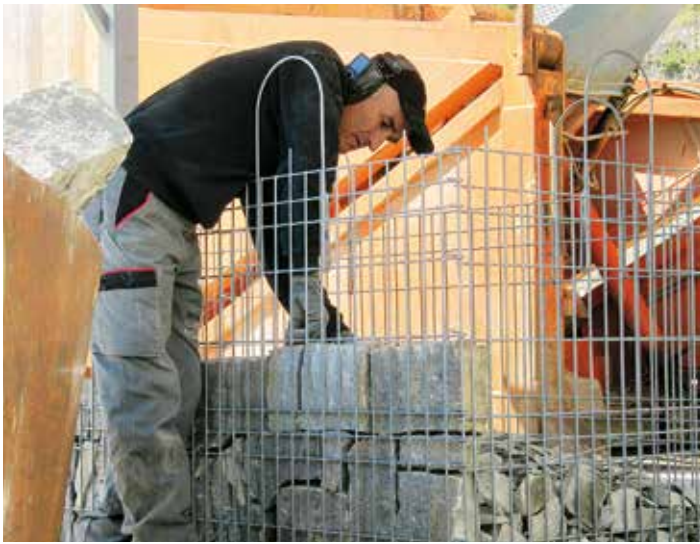
Empiler de gabions transportables
