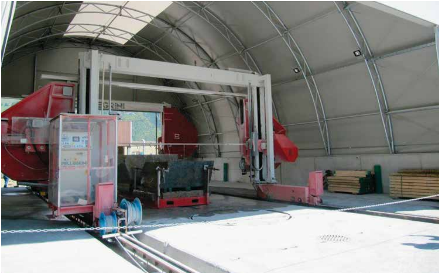
Scies à câble Pellegrini, année 2007 et 2012, dans galerie de tunnel
