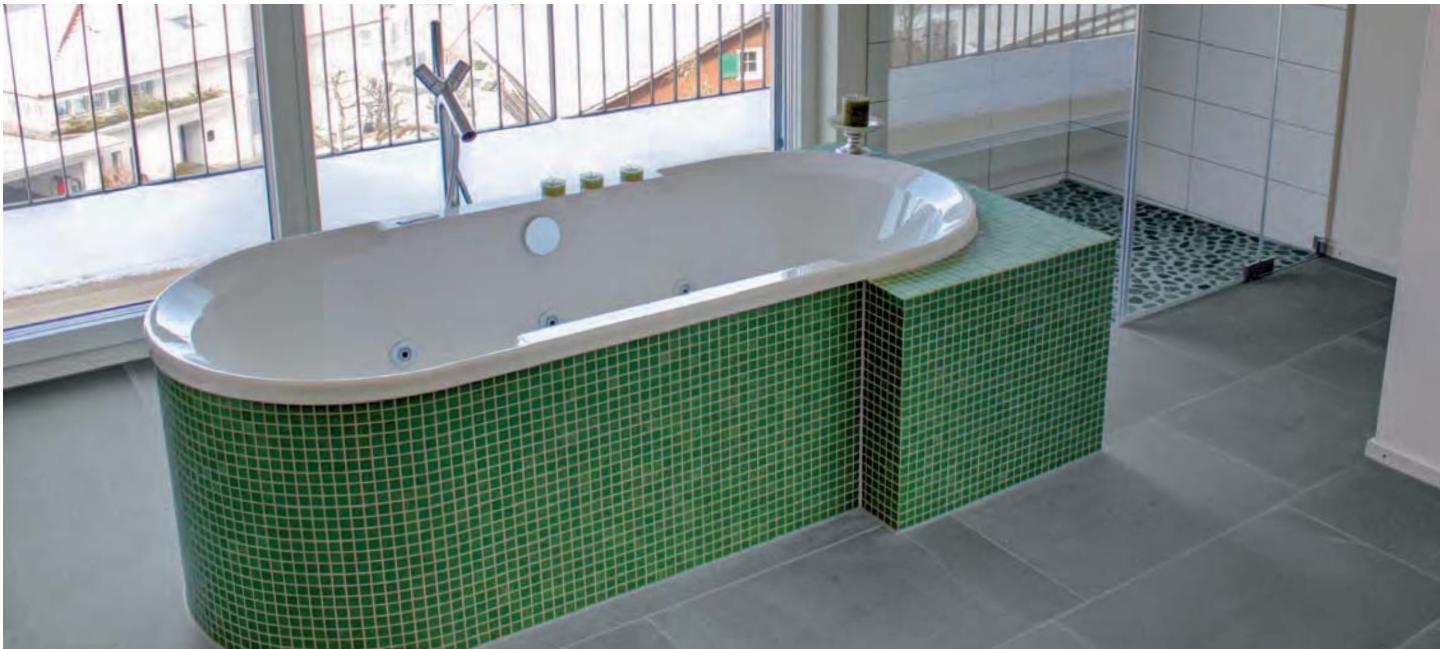
Revêtements de sol: dalles sciées à lames multiples, passées au jet d'eau et brossées. Largeur de la travée 45 / longueurs libres / épaisseur 2 cm
