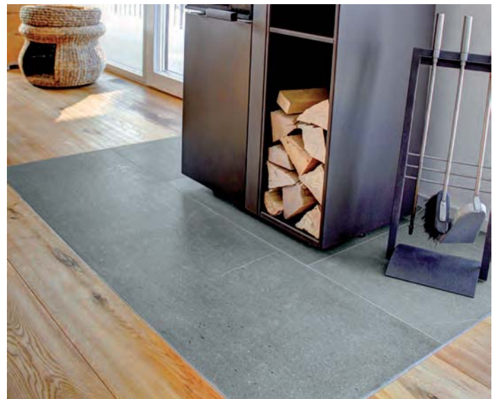
Revêtements de sol: dalles sciées à lames multiples, passées au jet d'eau et brossées
