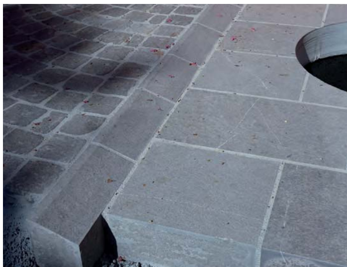
Détail des dalles de revêtement pour sols et pavage flammé (adapté aux handicapés) avec découpe de regard
