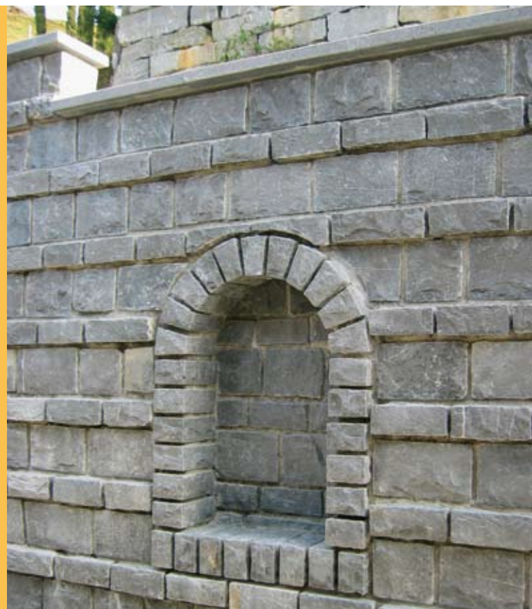
Maçonnerie en couches
